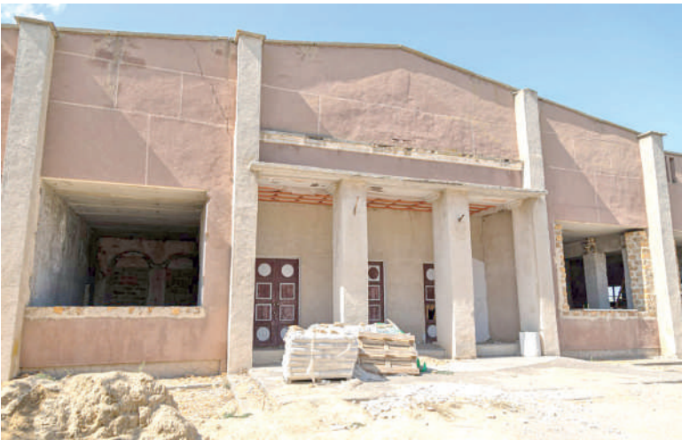
Дом культуры находится в состоянии капитального ремонта.
