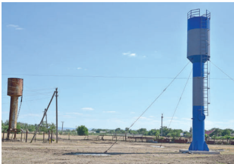
В селе Пчельники новая водонапорная башня.
