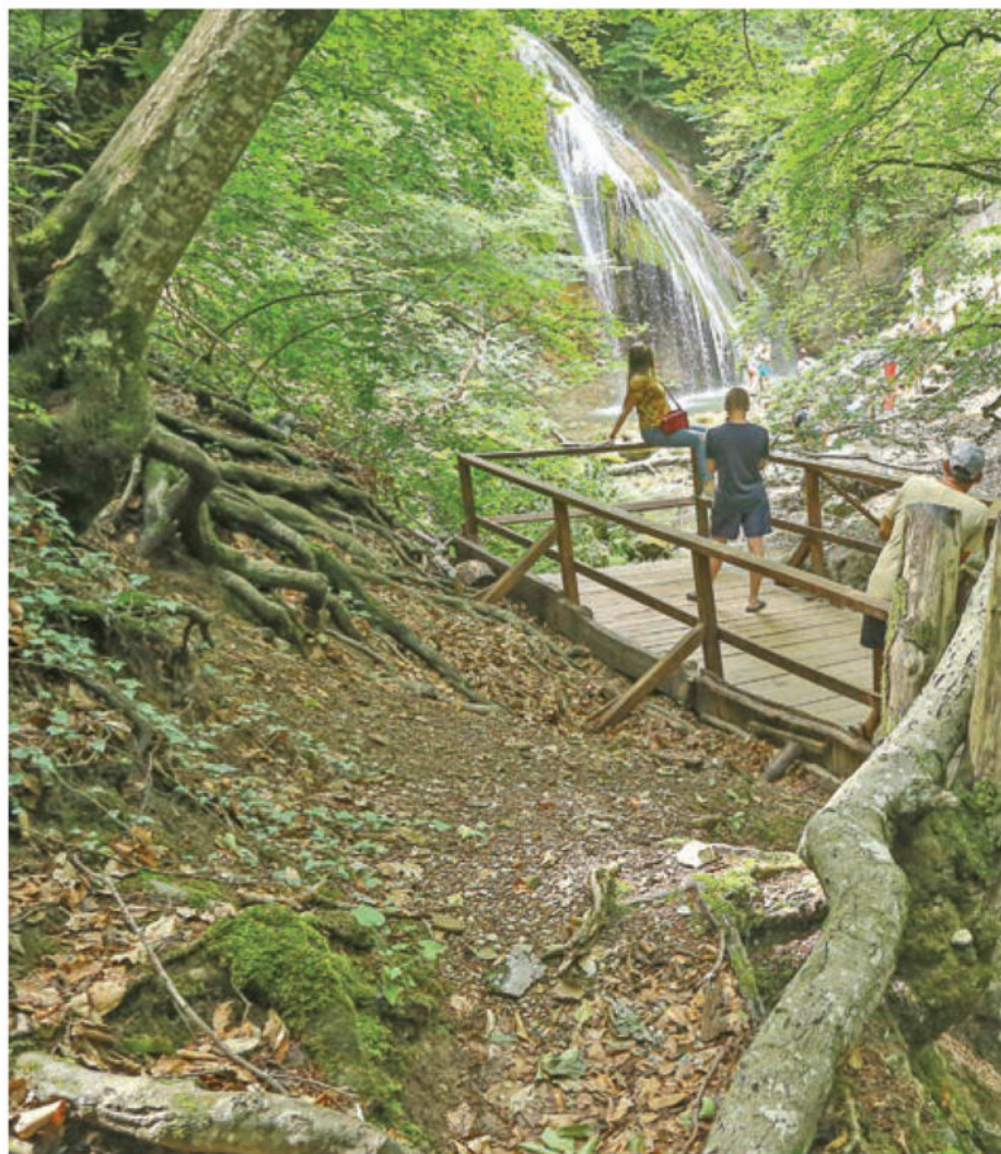
Деревянными настилами оборудованы новые смотровые площадки.
