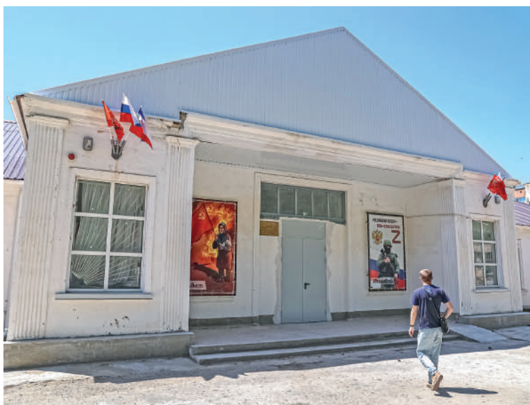
В Доме культуры сейчас идут ремонтные работы.
