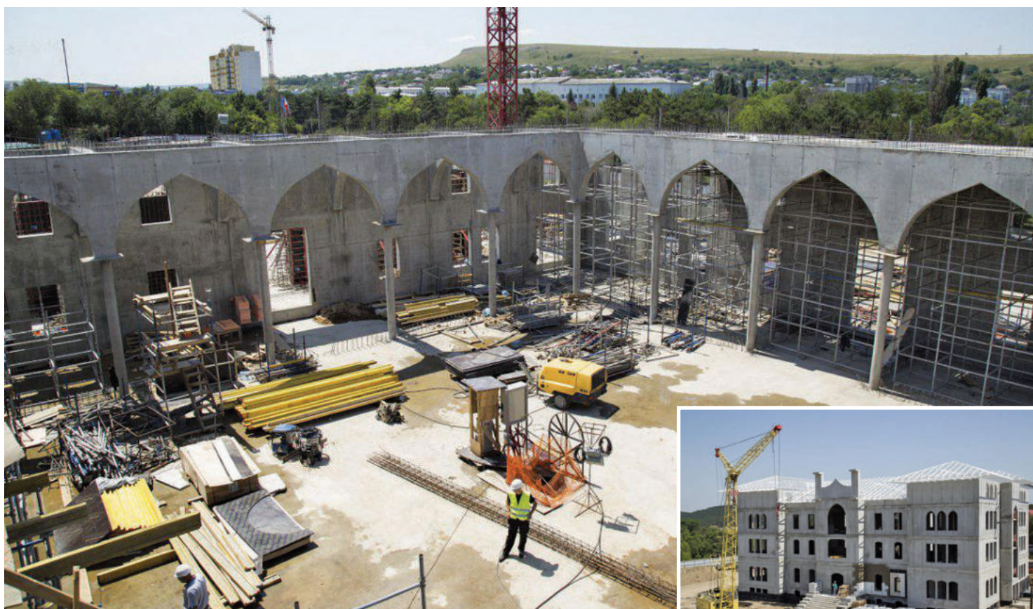
Продолжается строительство внутреннего дворика мечети, а здание муфтията почти завершено. Фото: Наталья ГОЦАНЮК. Больше фото на сайте gazetacrimea.ru
