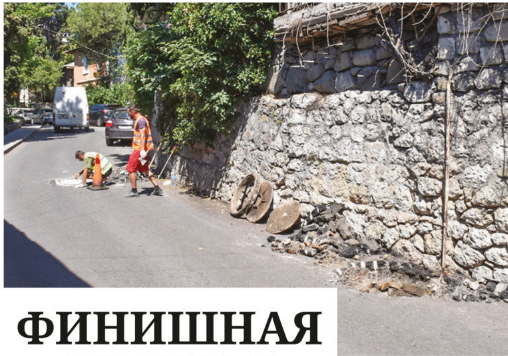
Ремонт на ялтинских улицах. Фото: yalta.rk.gov.ru
