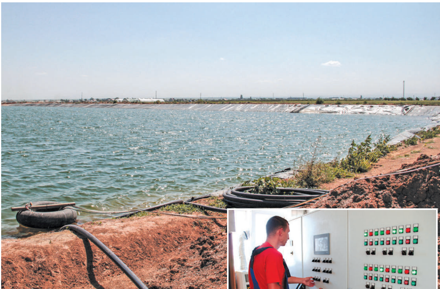
Резервуар-накопитель и пункт управления очистительной станции. Фото: Михаил ГЛАДЧУК
