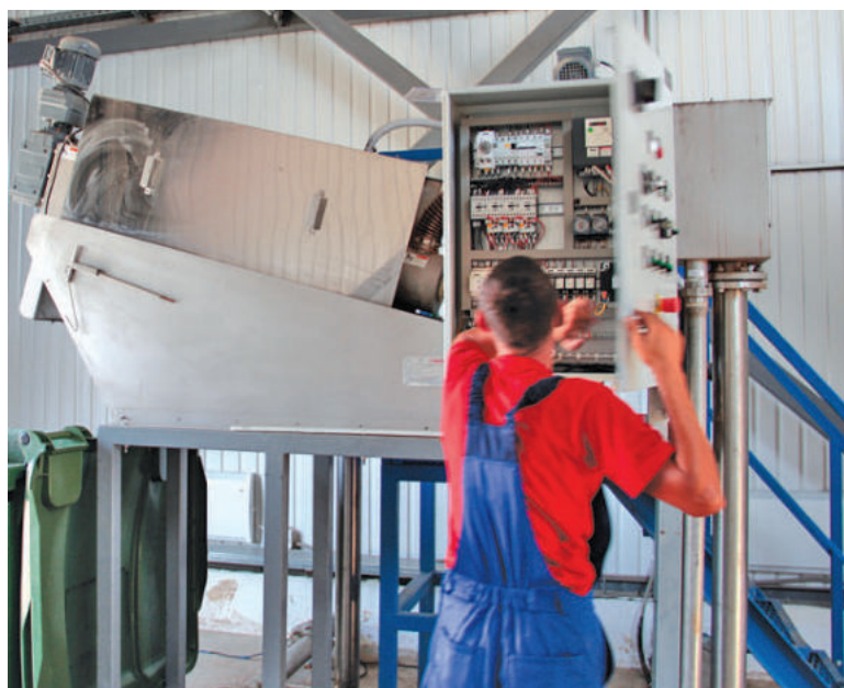
Работа с отходами очистительной станции.
