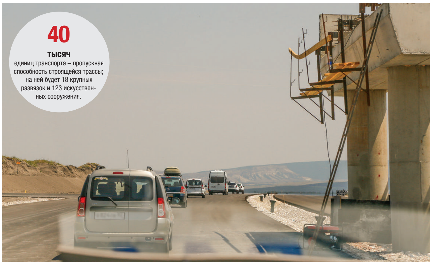
Строительство трассы ведётся параллельно: рабочие не только стелют дорожное полотно, но и строят мосты и развязки. Фото: Лидия ВЕТХОВА
