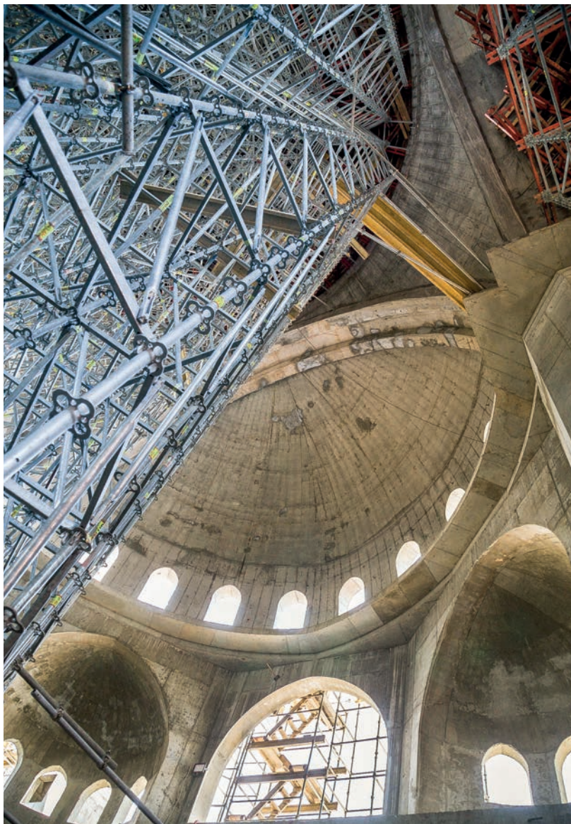
По этим металлоконструкциям на вершину купола ежедневно поднимаются строители. Все они первоклассные специалисты.
