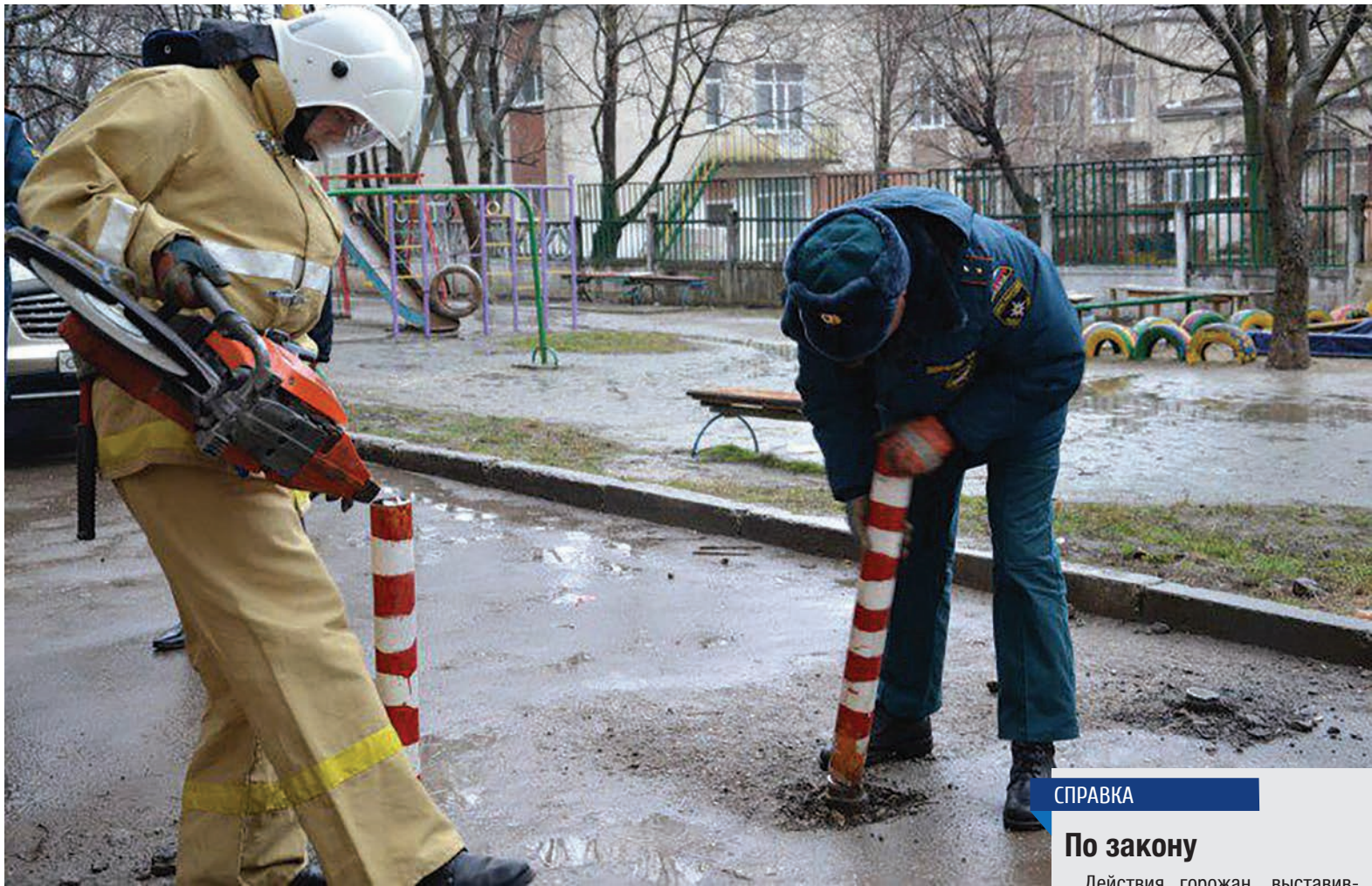
Жителей могут оштрафовать за блокировку двора, в том числе столбиками. Фото из открытых источников.
