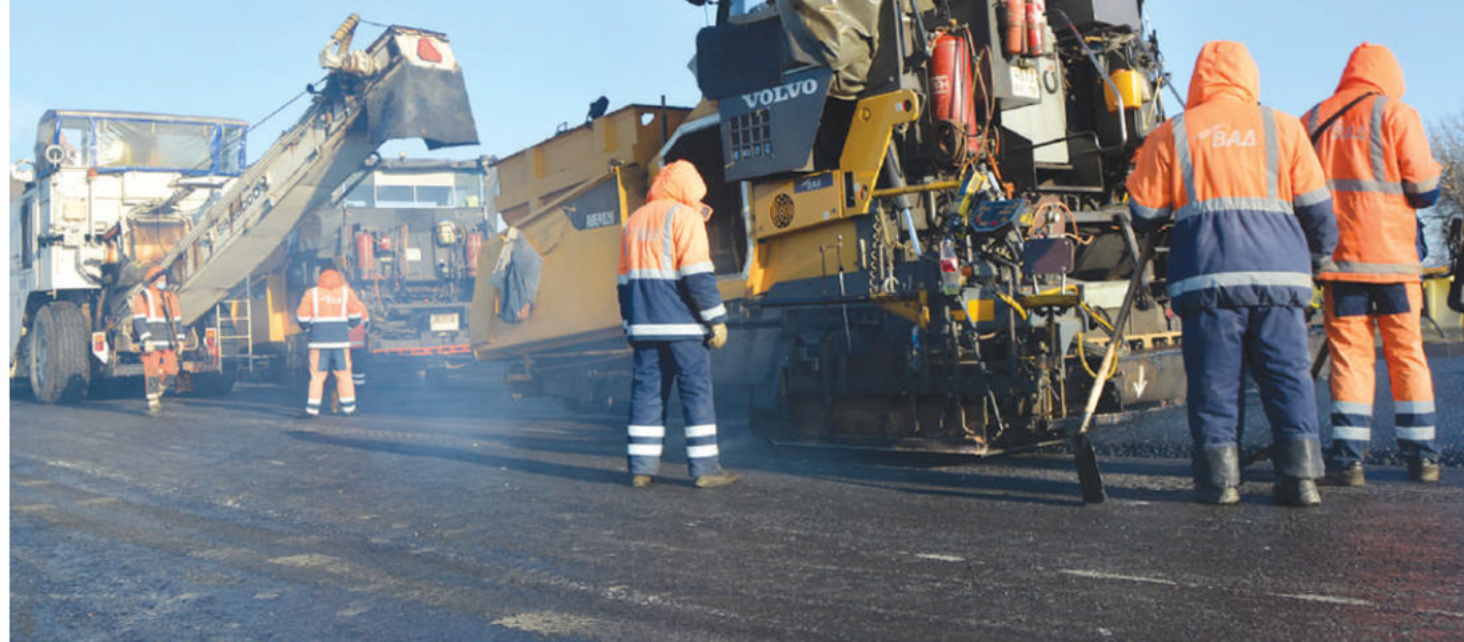
Дорожники укладывают финишный слой асфальтобетона на третьем этапе строительства трассы «Таврида» Фото: Гала АМАРАНДЮ
