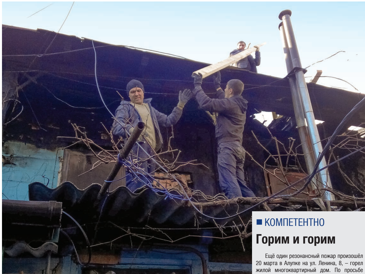
Утро после пожара. Жильцы ведут ремонт своими силами.
