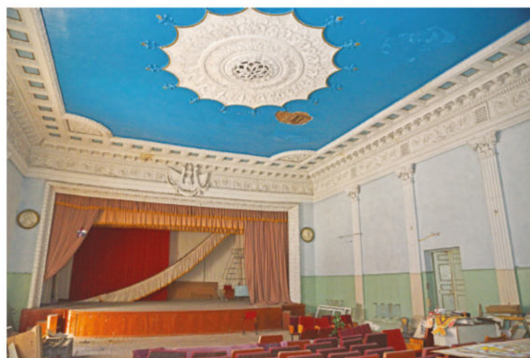
Большой зал ДК ждёт капитального ремонта.
