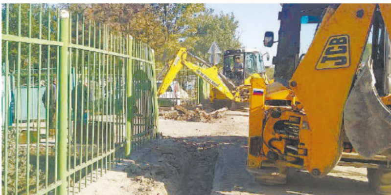
Ремонт дороги с выходом к объектам социальной и транспортной инфраструктуры в Чистенском сельском поселении. Фото: администрация Симферопольского района
