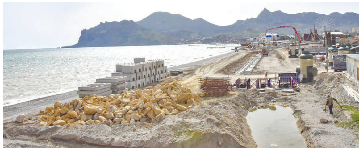
Ведутся работы по реконструкции набережной.
