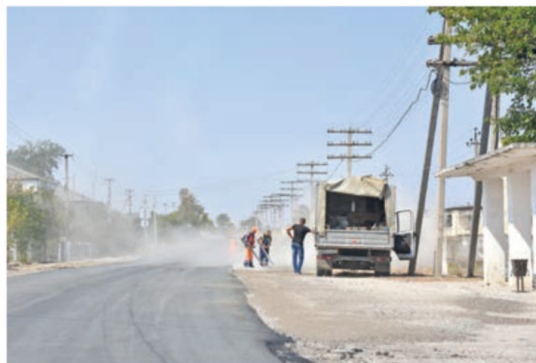
На улице Кирова идёт ремонт дороги. Скоро здесь появится и освещение.
