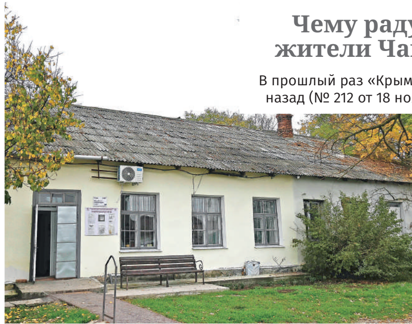
В здании амбулатории провели долгожданный ремонт.
