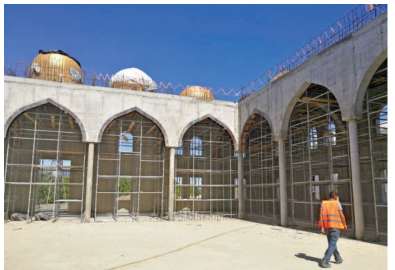
Строящаяся мечеть Джума-Джами в Симферополе. Фото: Владимир ПРОШКИН.
