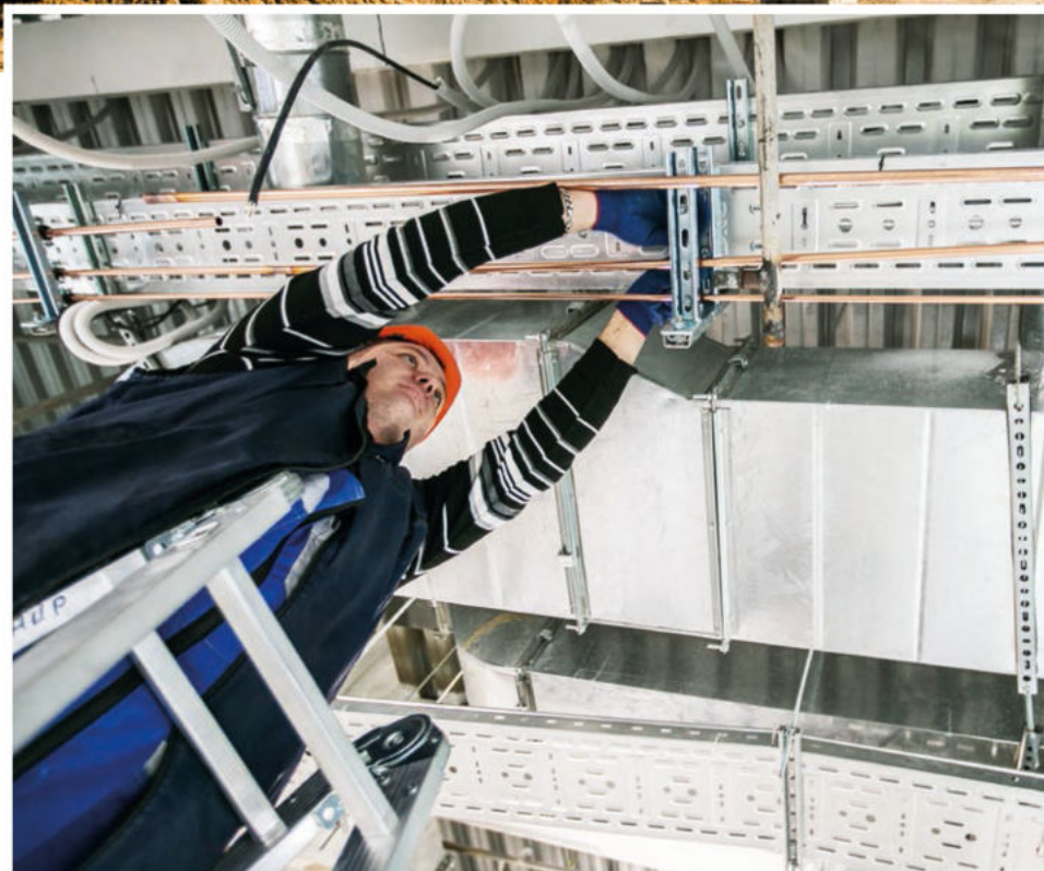
Строители приступили к монтажу системы централизованной подачи медицинских газов. Фото: Лидии ВЕТХОВОЙ
