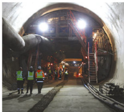
Строители пробили километровый тоннель для железнодорожной ветки к Крымскому мосту. Фото: most.life
