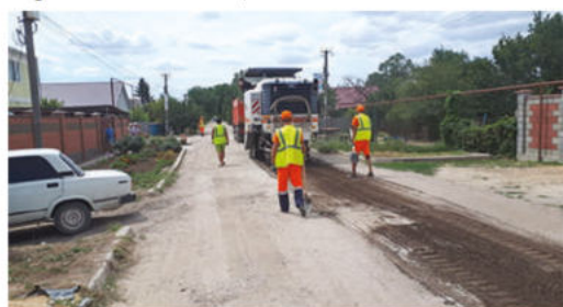
Дорожные работы в селе Софиевка. Здесь отремонтируют улицы Центральную и Солнечную. Фото: rk.gov.ru
