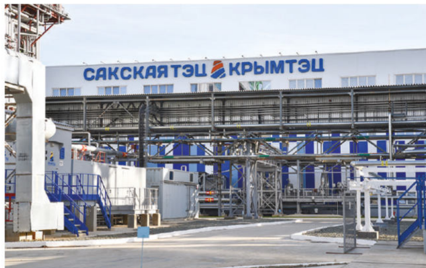
Сакская ТЭС генерирует не только электрическую, но и тепловую энергию. Фото: Наталья СОМОВА
