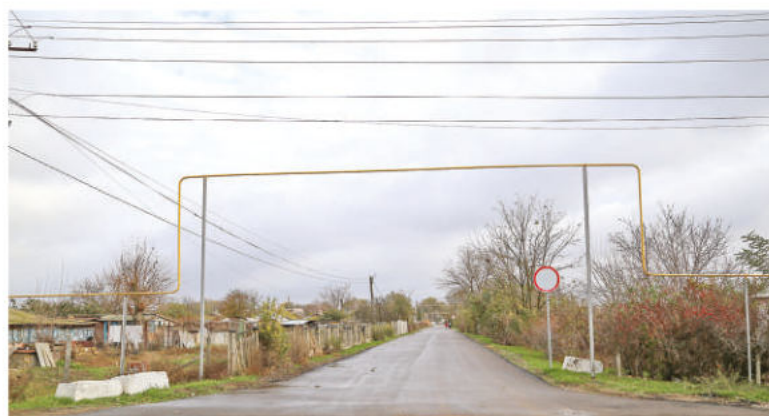
Часть улицы Богдана Фрика заасфальтировали и осветили. Эту работу скоро продолжат, и улица будет благоустроена полностью.
