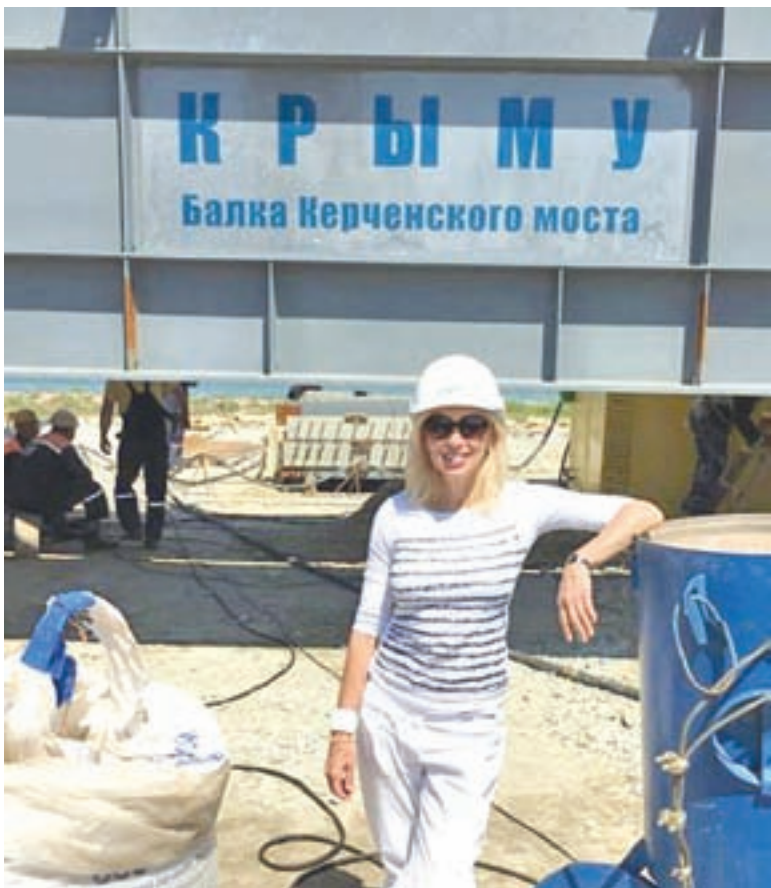
Алена Свиридова инспектирует строительство Крымского моста.
