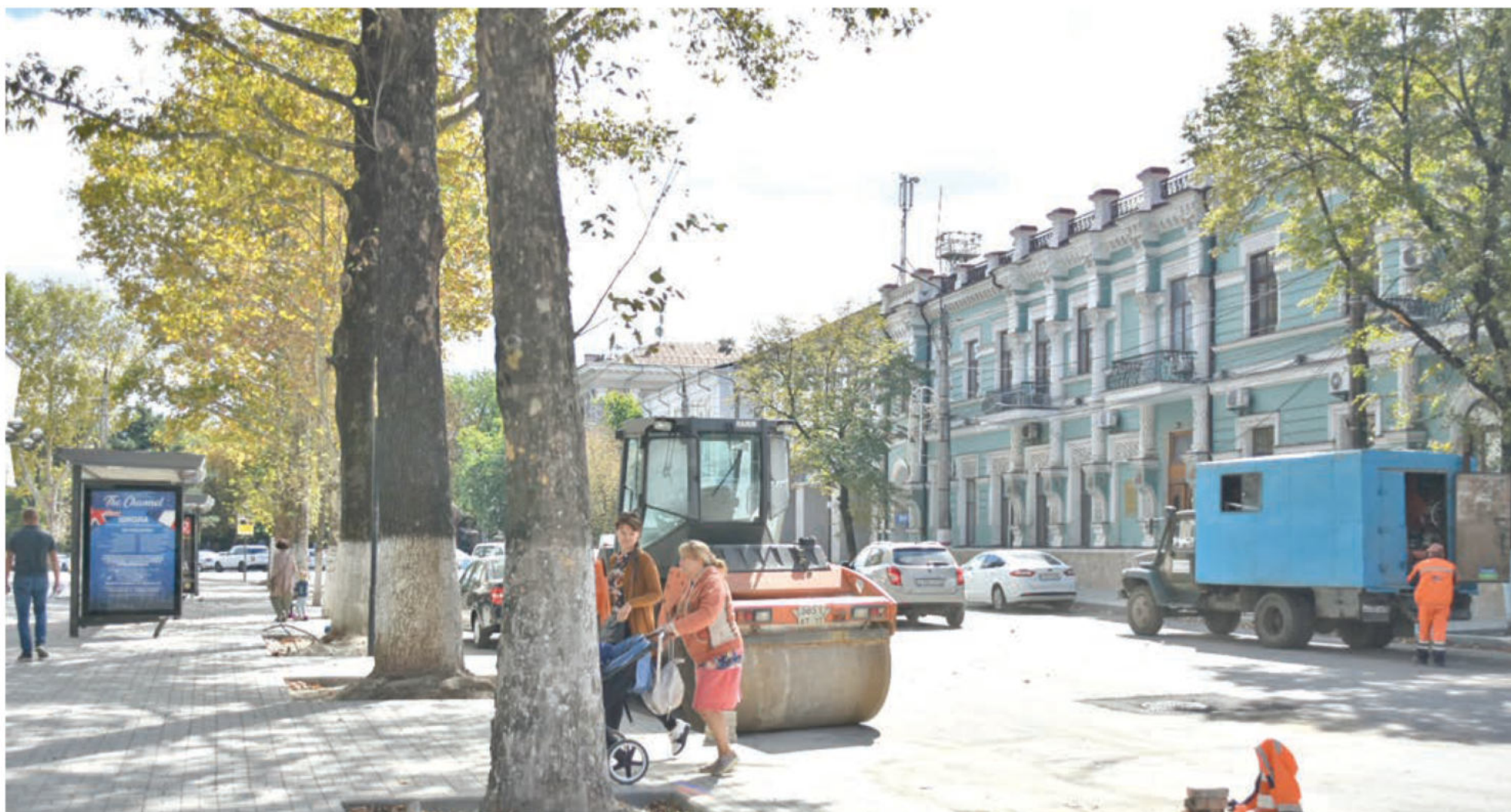
Симферополь преобразуется. Реконструкция участка улицы Александра Невского у почтамта. Фото: Владимир ПРОШКИН.
