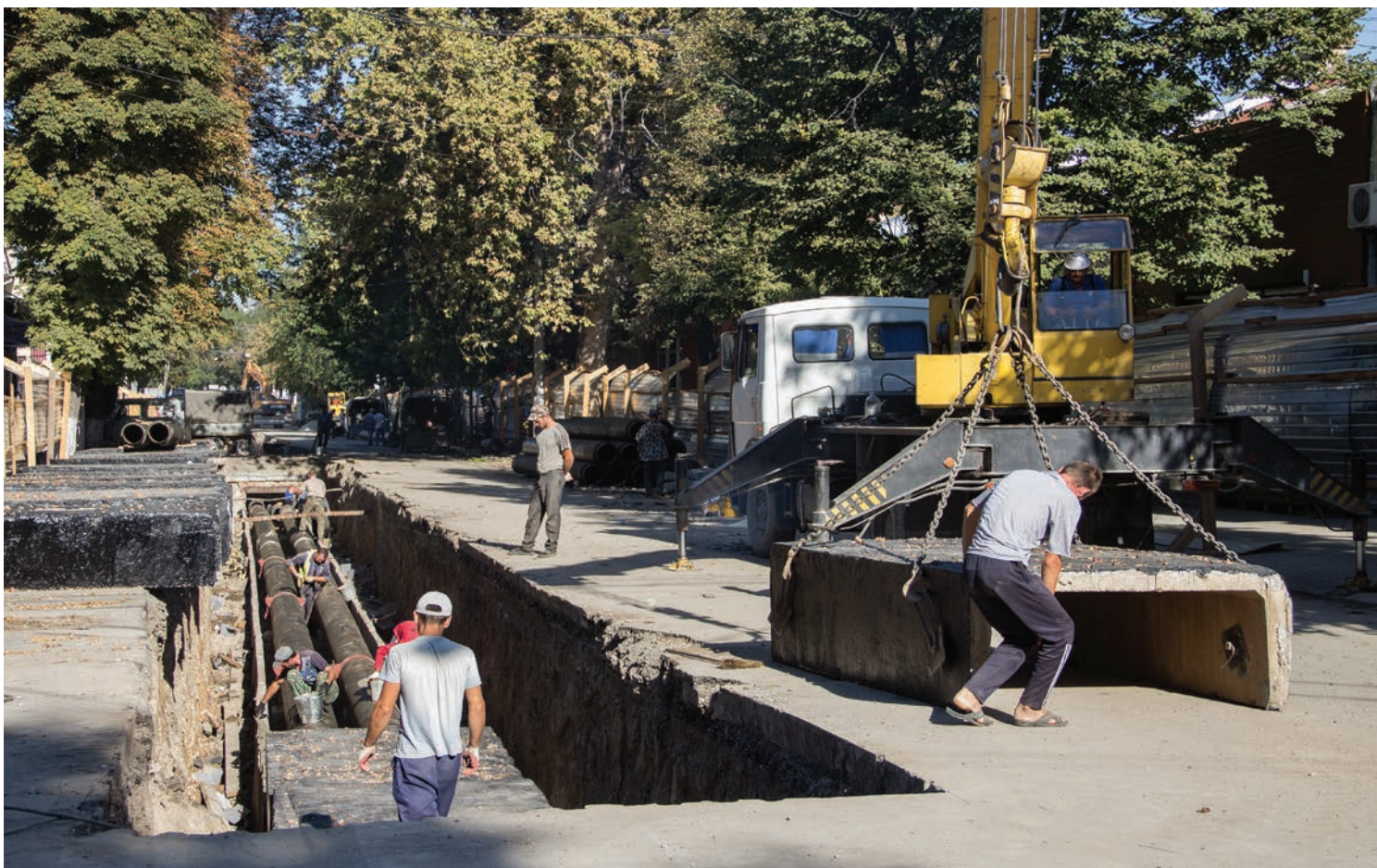
15 сентября. Симферополь, ул. К. Маркса. Прокладку теплотрассы здесь должны закончить до холодов. Фото: Михаил ГЛАДЧУК
