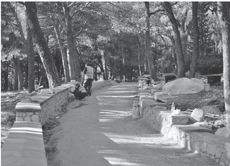
В Мисхорском парке ведут капитальный ремонт. На площадке 30 рабочих и малогабаритная техника. Фото: горадминистрация Ялты
