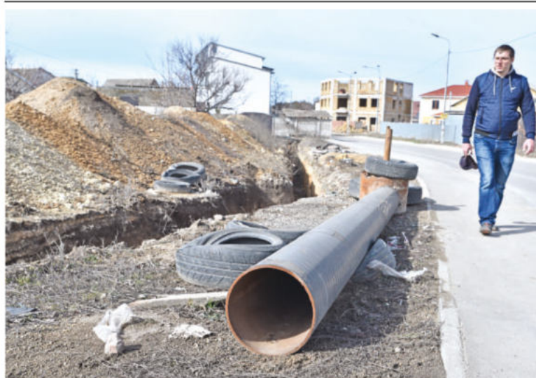
Замена труб идёт неторопливо, и рабочих не видно.
