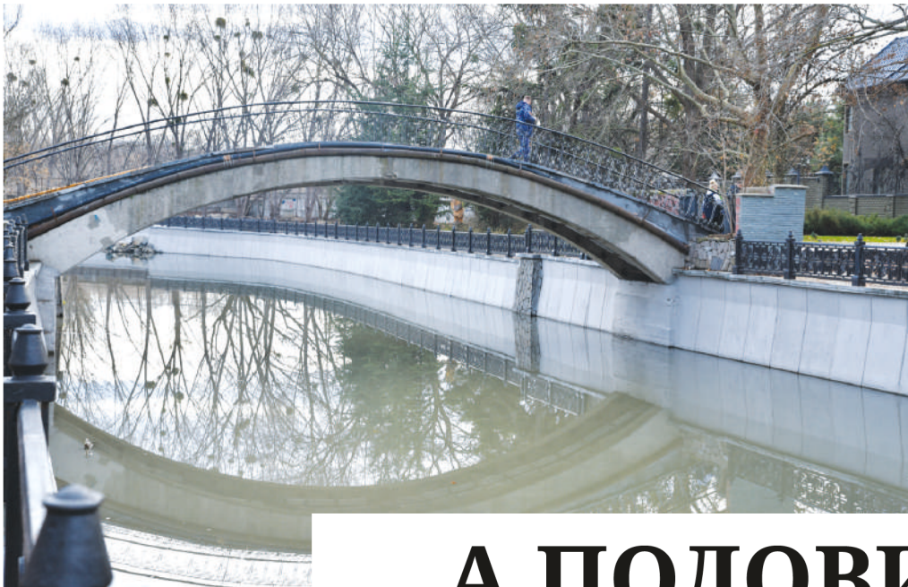
Река Салгир в Симферополе тоже ждёт очистки. Фото: архив газеты
