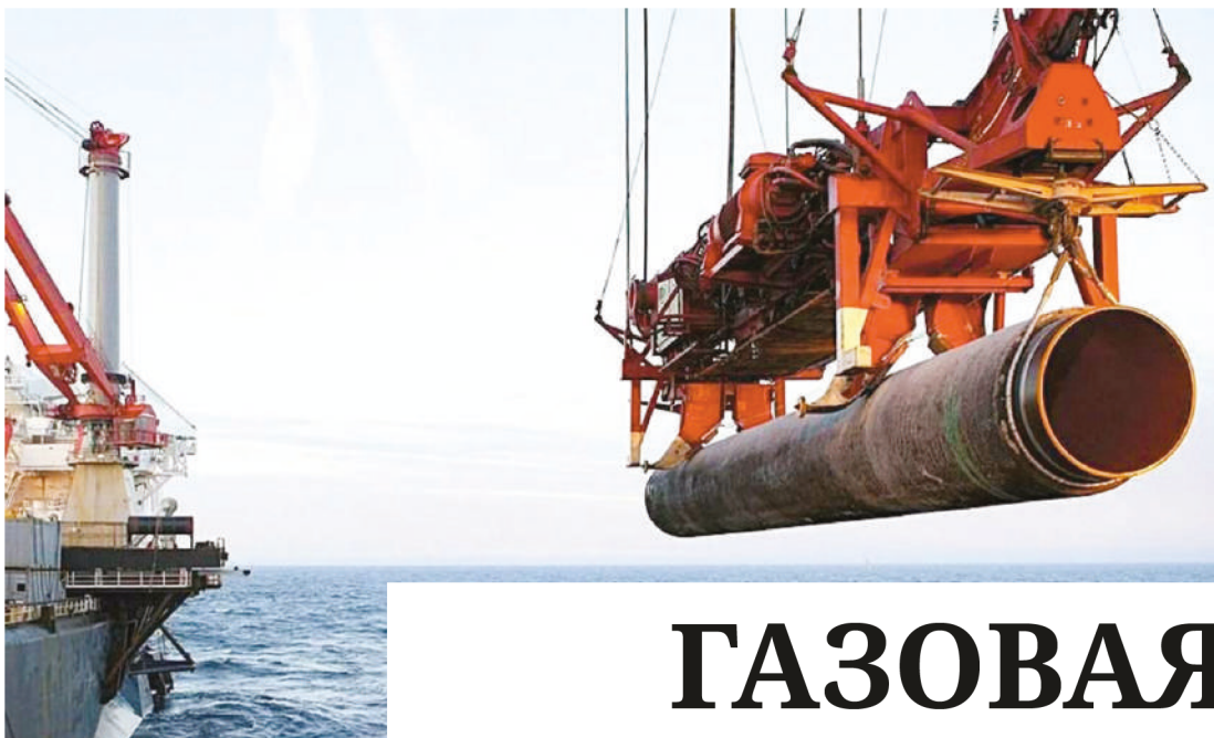
Газопровод «Северный поток – 2» будет достраивать баржа «Фортуна». Фото: apral.ru
