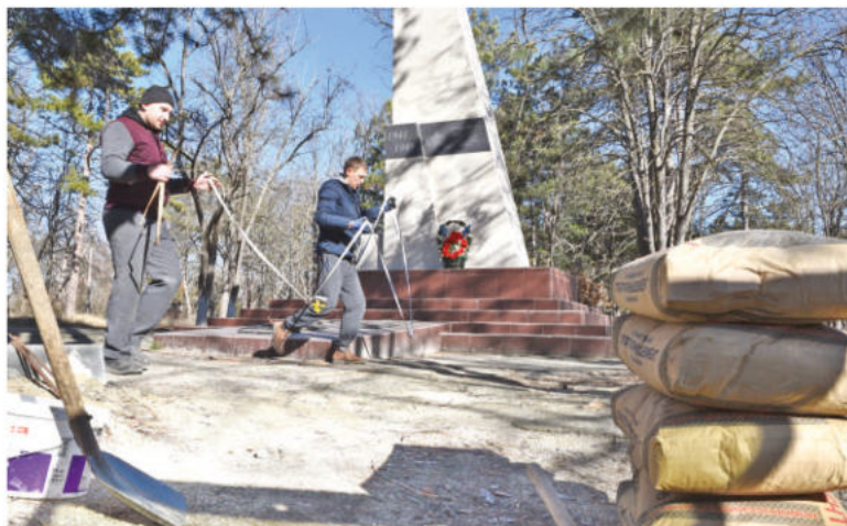
Второй этап укладки плитки возле братской могилы.
