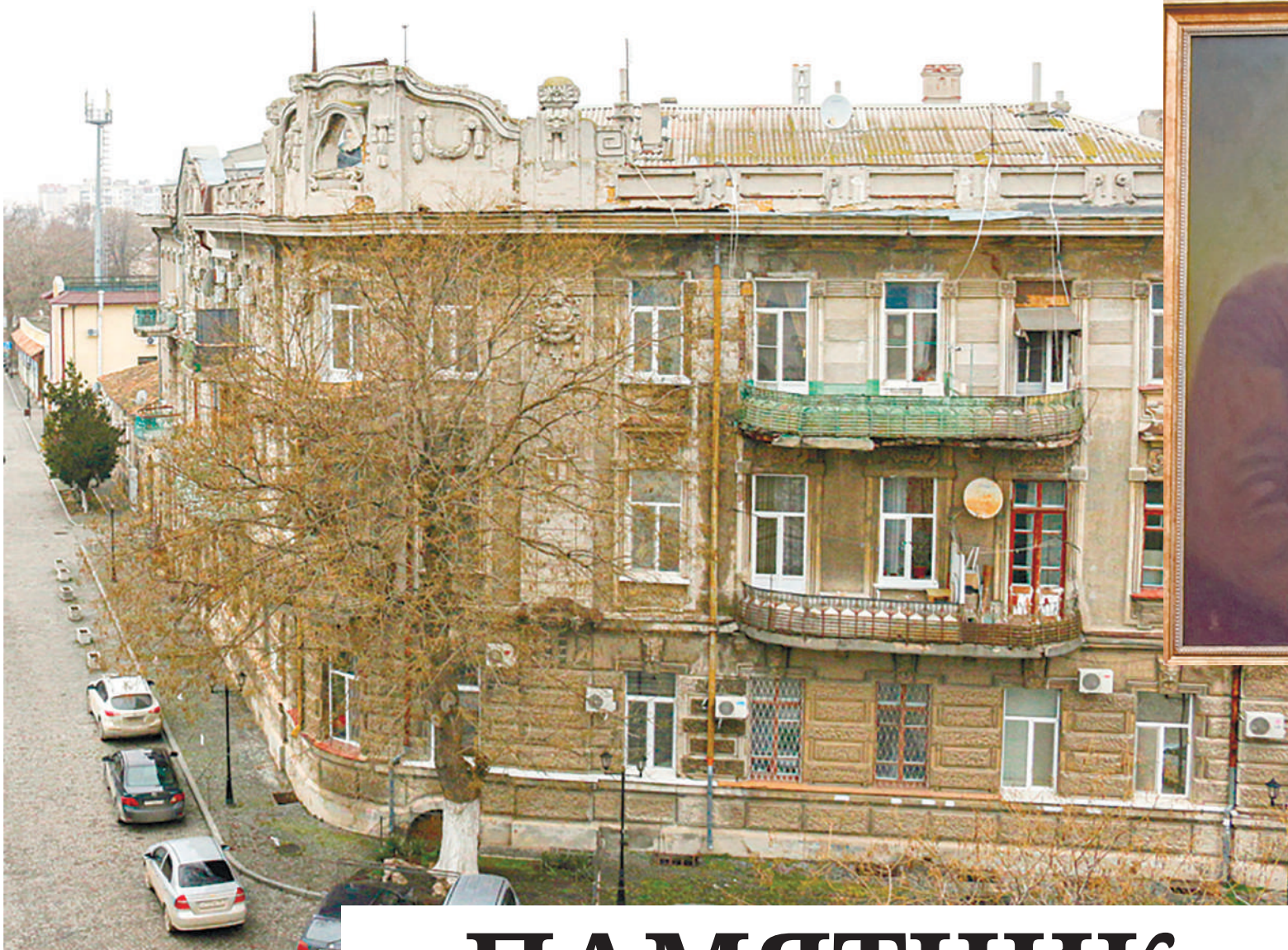
Каждая деталь фасада Доходного дома Дувана – это шедевр.
