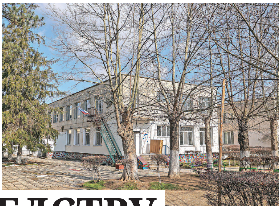
Капремонт детского сада по графику должны завершить к 1 сентября.
