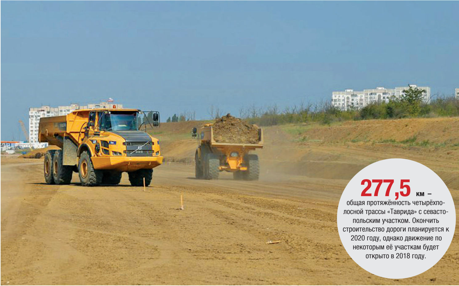
17 июля. Строительство федеральной трассы «Таврида» идёт полным ходом. Фото: Наталья ГОЦАНЮК. Больше фото на сайте gazetacrimea.ru
