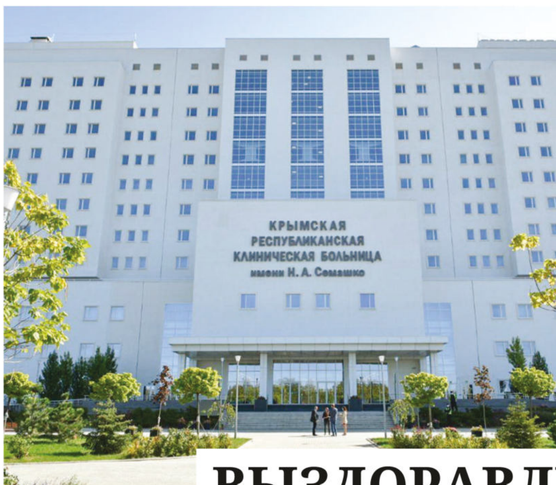
Строительно-монтажные работы завершены. Идёт дооснащение объекта современной аппаратурой. Фото: Михаил ПАТЛИС
