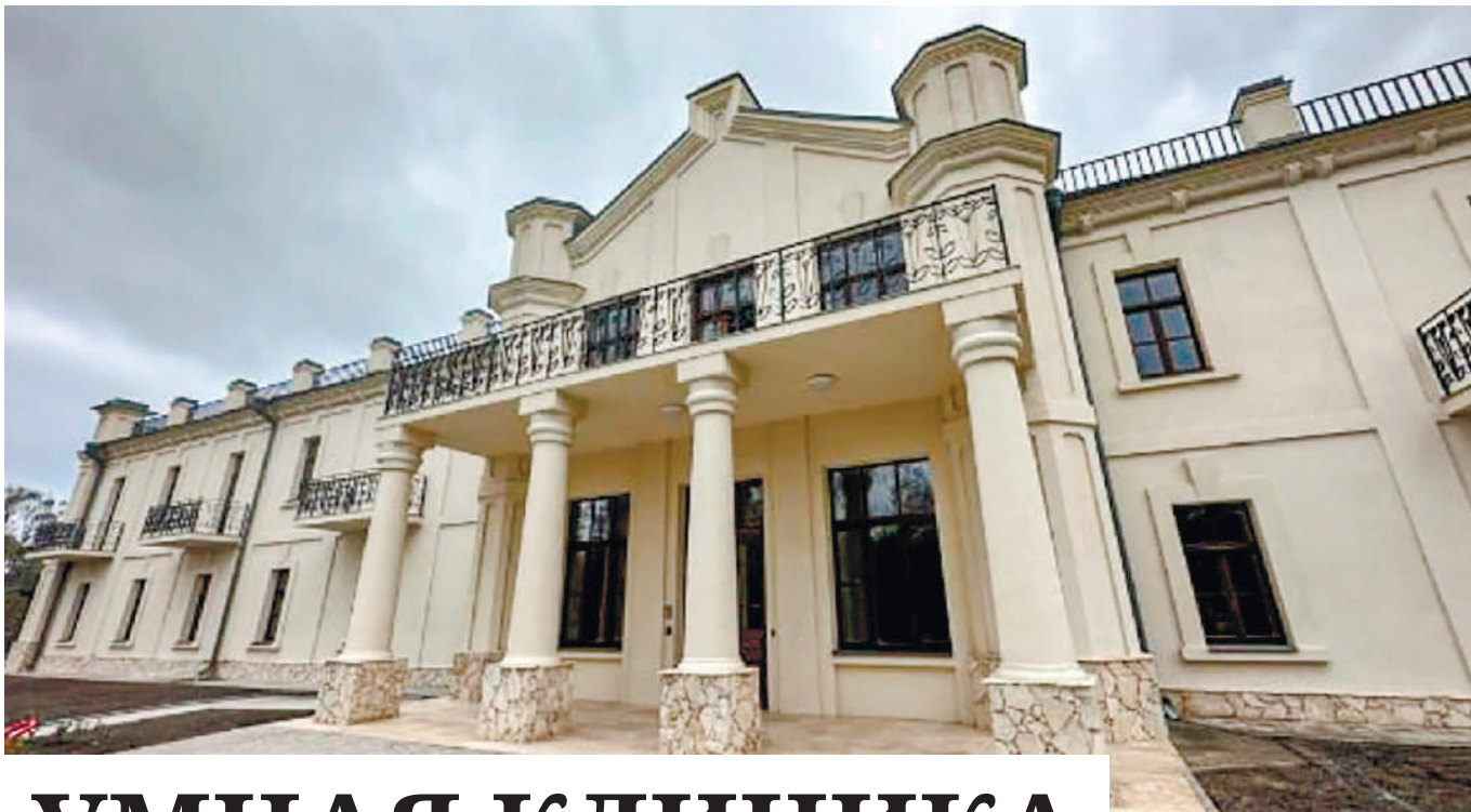
Фото: пресс-служба ППК «Единый заказчик в сфере строительства»
