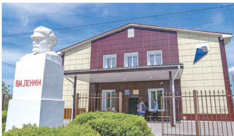
ДК после ремонта выглядит так, будто его отстроили с нуля.
