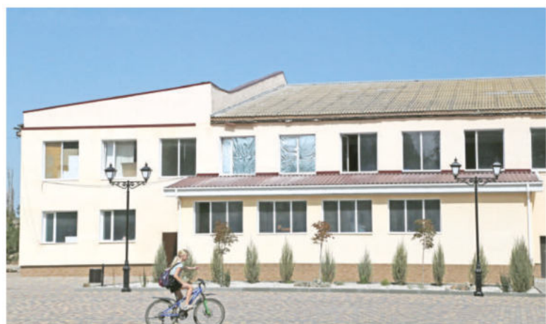
Дом культуры частично отремонтирован.
