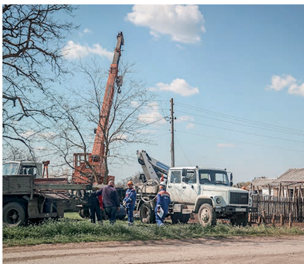
На улице Садовой проходит замена опор ЛЭП.
