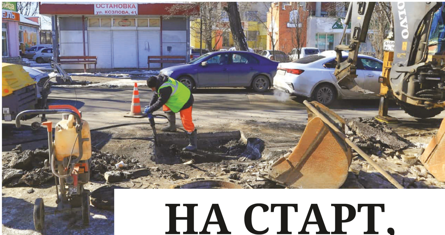
17 февраля. Симферополь. На улице Козлова дорожные рабочие и техника ведут активные подготовительные работы. Фото: Наталья СОМОВА
