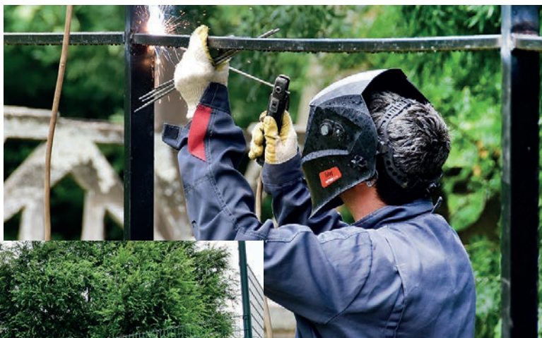
Идёт установка ограждения территории школы.
