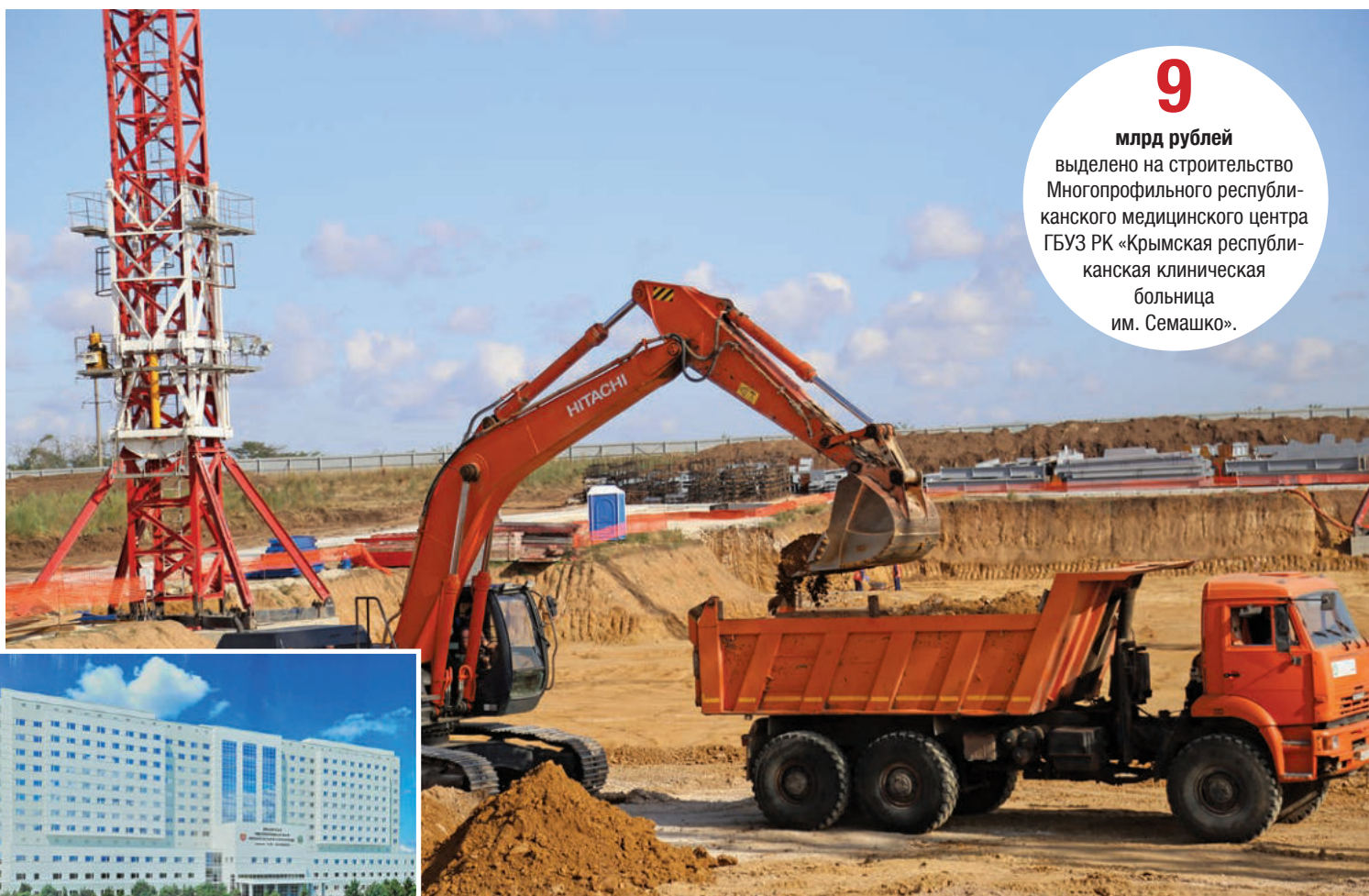
5 сентября. Симферополь, 11-й км Московского шоссе. Началось строительство многопрофильного медицинского центра. Фото: Владимир ПРОШКИН
