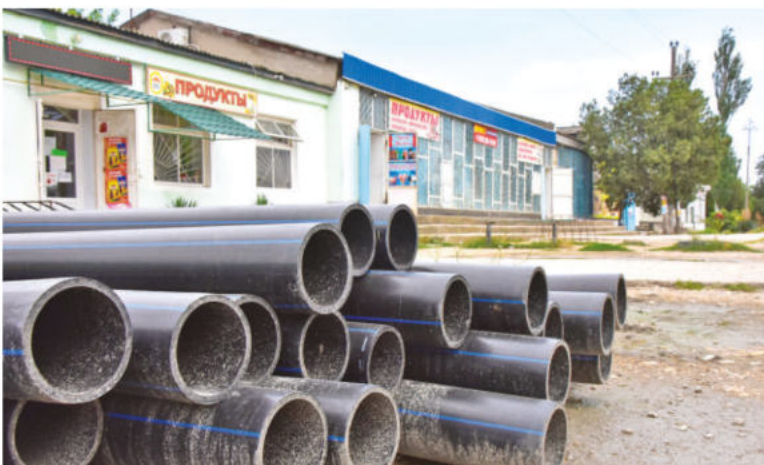
Идёт ремонт централизованного водоснабжения.
