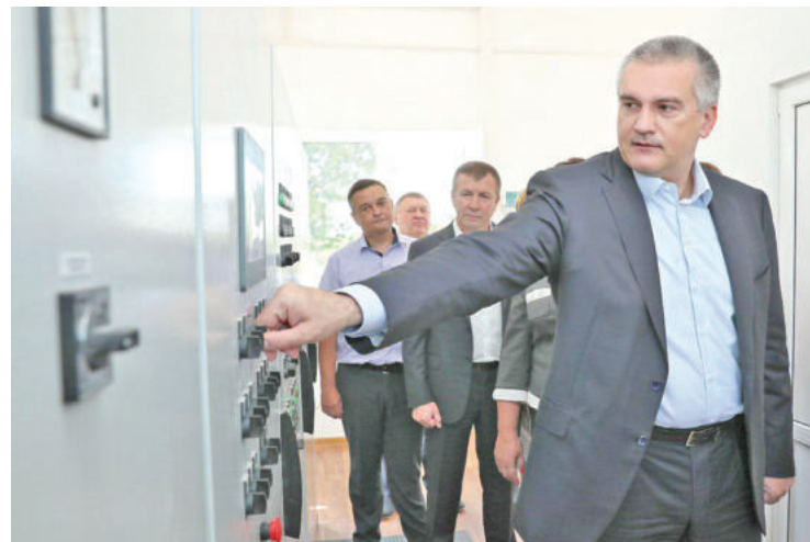
Запуск очистных сооружений в Гвардейском. Фото rk.gov.ru
