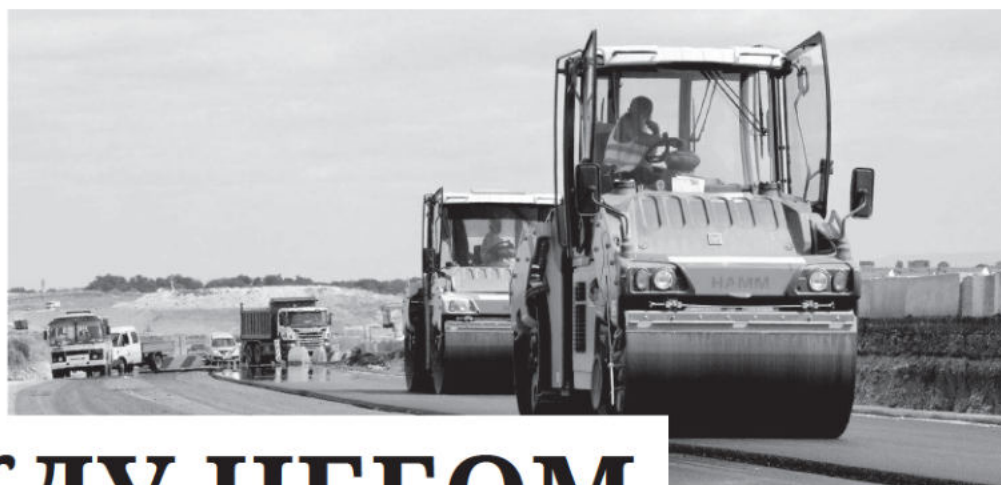
В начале июля будут заключены договоры на 15 объектов дорожного строительства. Фото: Гала АМАРАНДО
