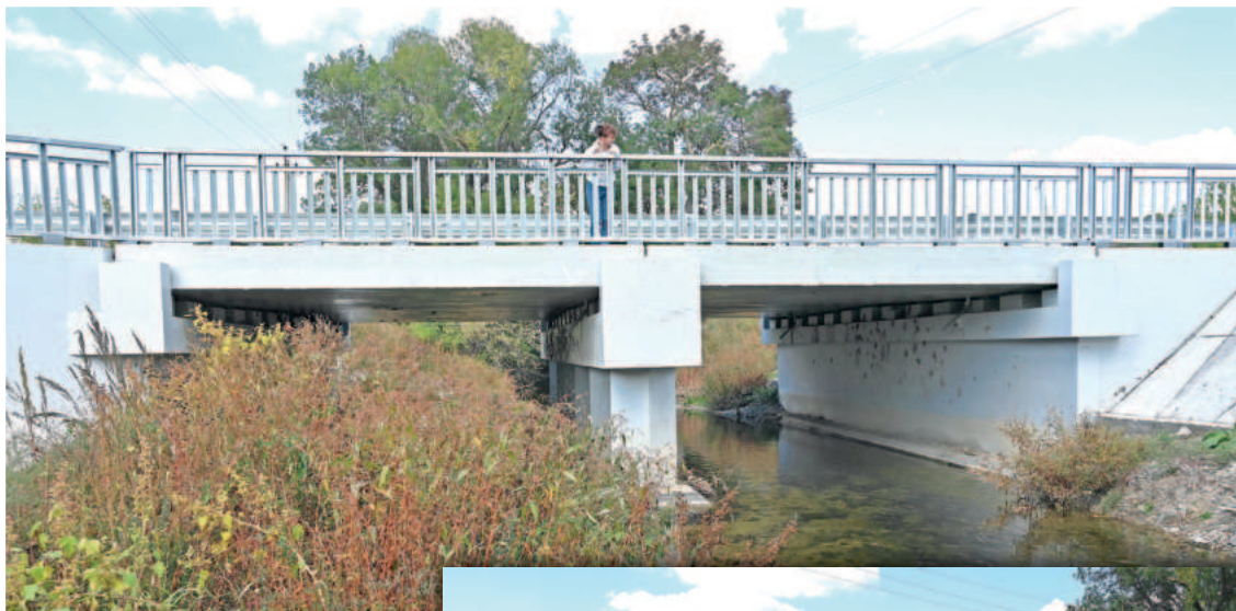
В начале года был завершён капремонт моста через реку Биюк-Карасу.
