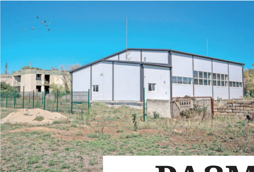
Готовится к открытию физкультурно-оздоровительный комплекс.
