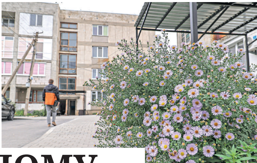
Дворовые территории МКД благоустроили, а самим домам отремонтировали кровли.
