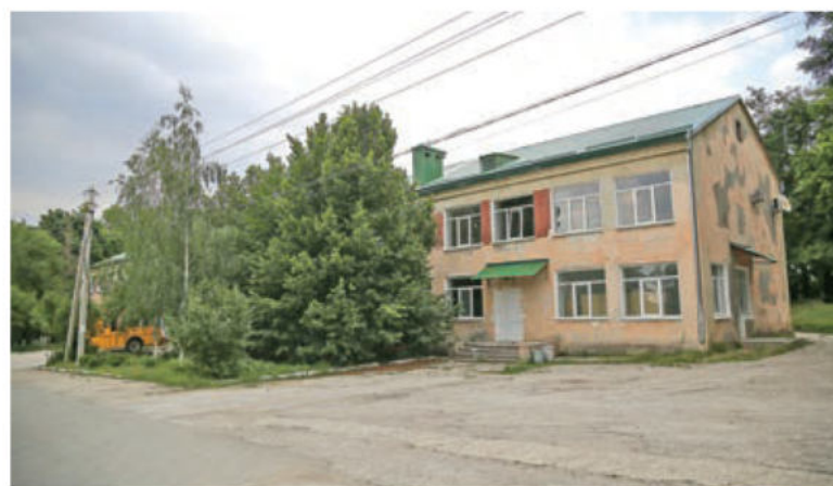
Фасад здания школы ремонтируют.
