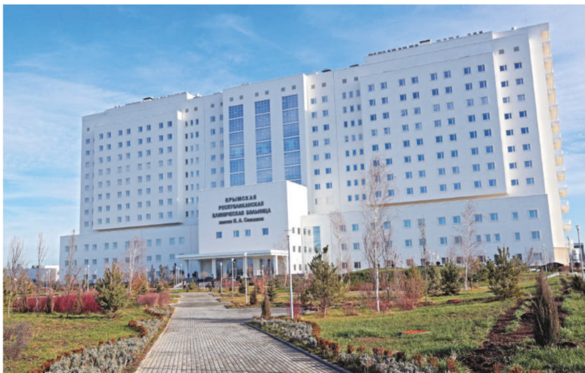
Каждый новый объект, строящийся в Крыму, повышает статус курорта. Фото: Лидия ВЕТХОВА.
