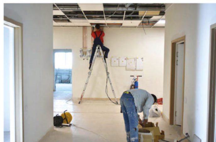
В здании продолжается монтаж систем.
