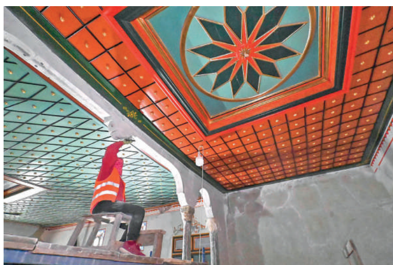
Потолки – подшивные, деревянные, наборные, с «сетчатым» рапортом из фигурных реечек.
